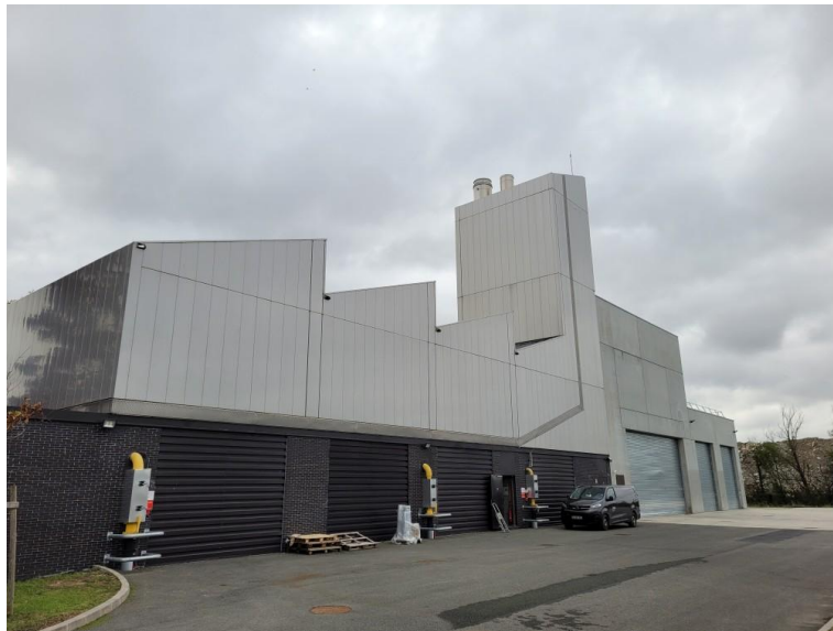
Figure 1 : chaufferie du réseau de chaleur urbain Plaine de Garonne Energies. Source : Bordeaux Métropole
