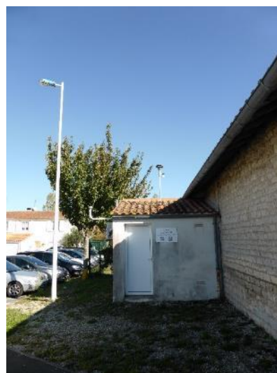
Figure 5 : Station de mesure fixe Aytré avenue Edmond Grasset
