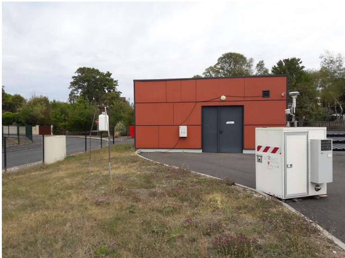
Figure 2 : Site de mesure Pierrières
