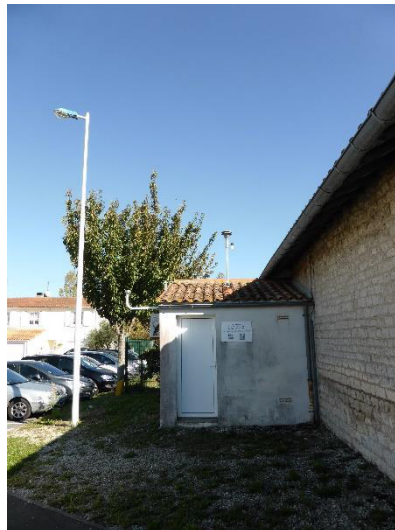
Figure 4 : Station de mesure fixe Aytré
