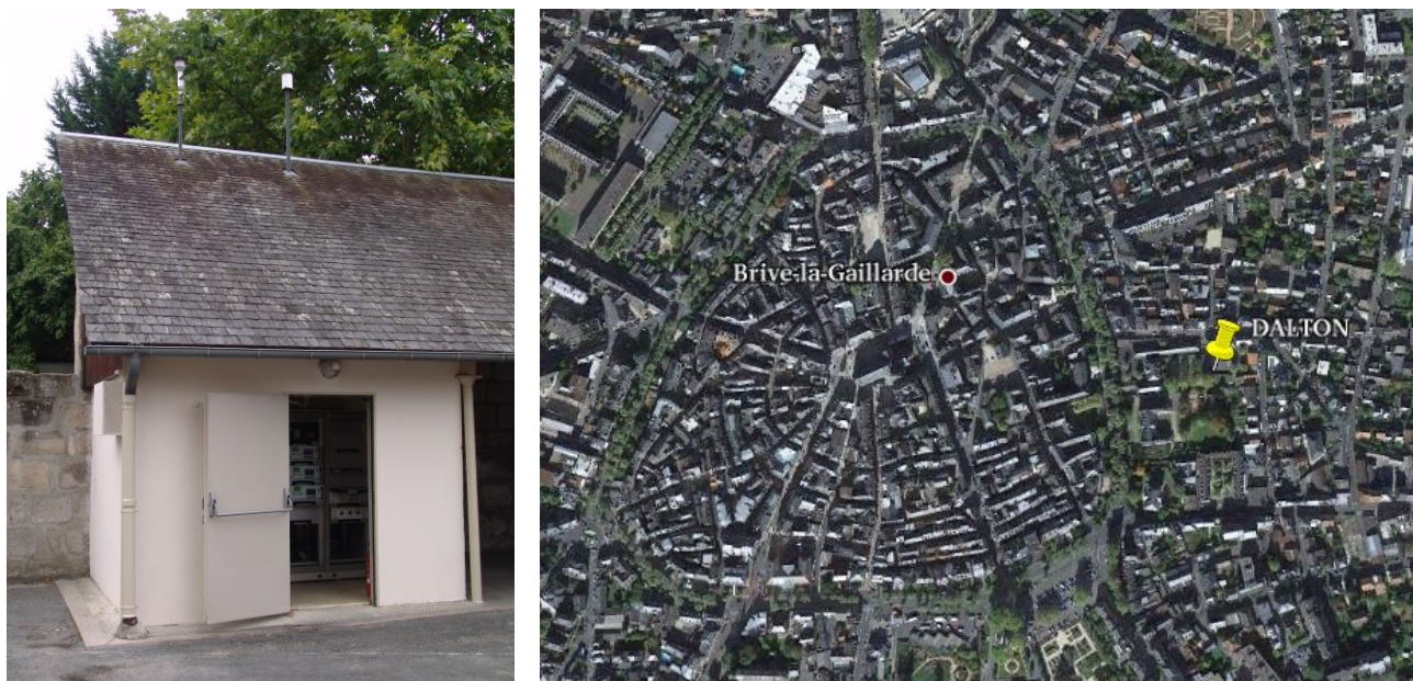
Figure 2 | Implantation de la station de mesure fixe de Brive-la-Gaillarde
