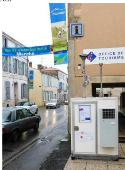
Figure 2 | Implantation de la station mobile de mesure à Marans
