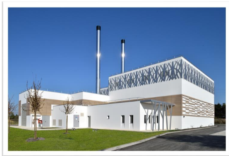
Figure 1 : La chaufferie des Akènes, source INGEROP
