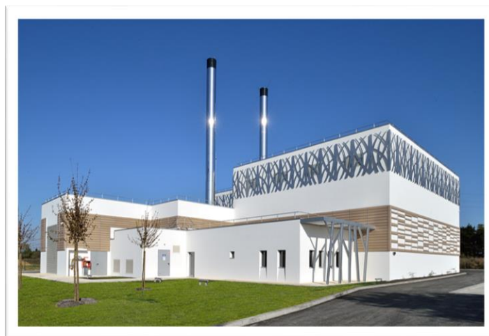
Figure 1 : La chaufferie des Akènes, source INGEROP
