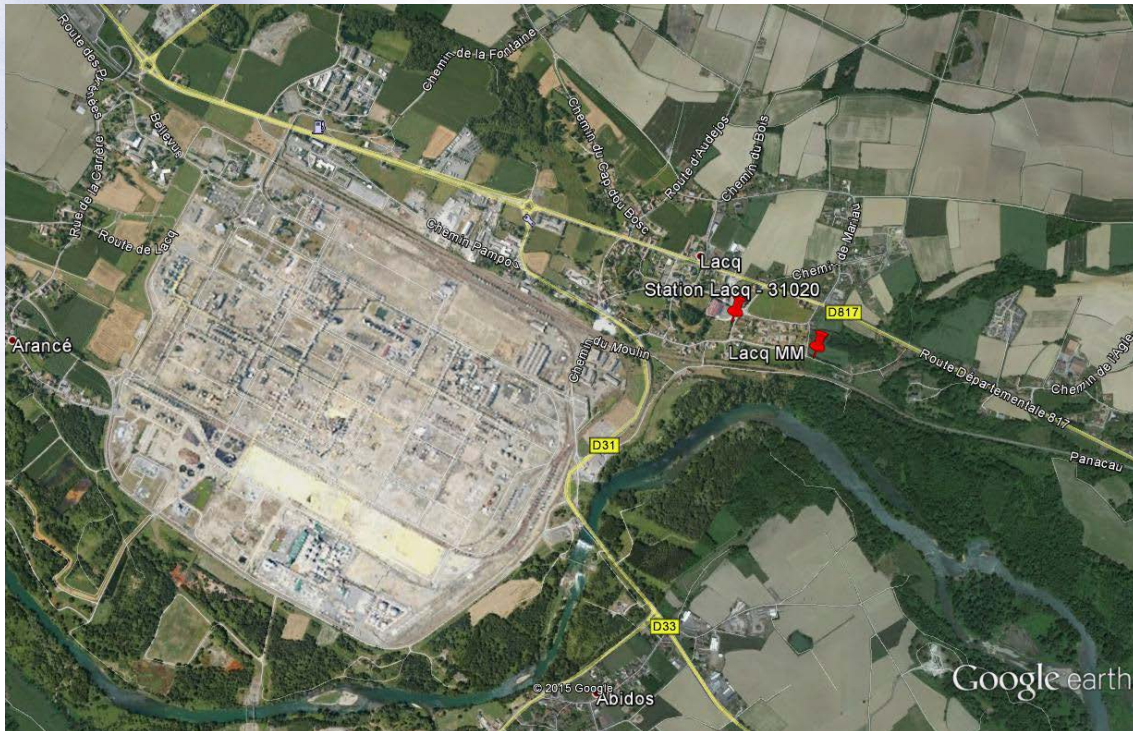
Figure 1 : vue aérienne globale de la zone d'études
