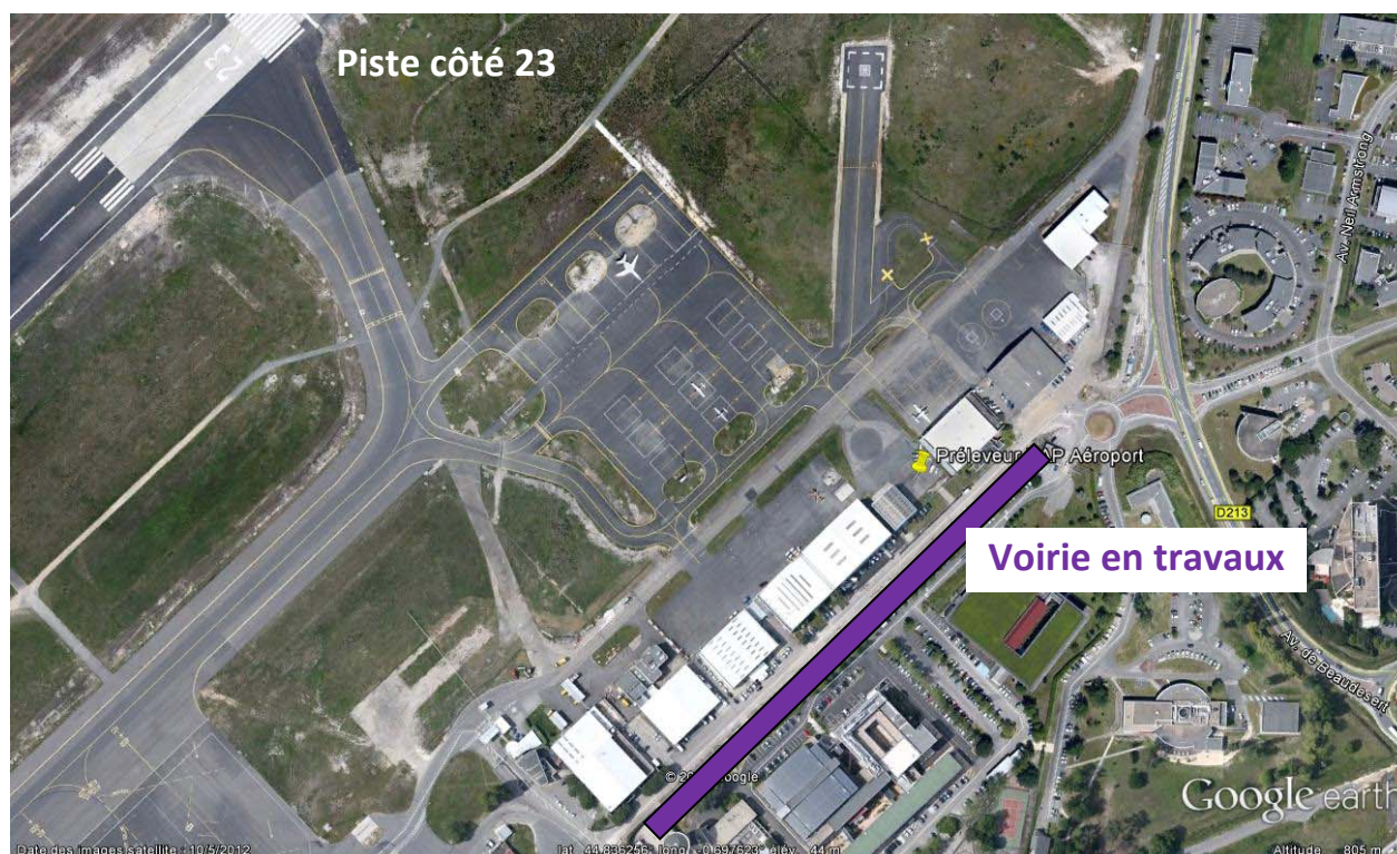
Figure 18 : Vue aérienne resserrée du préleveur
