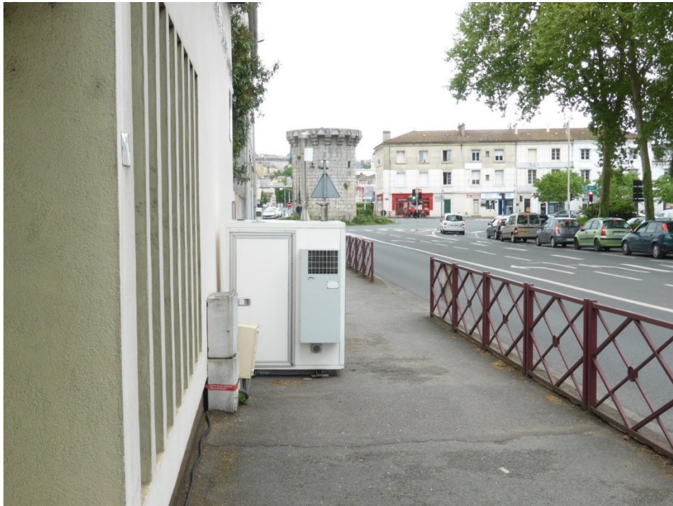
Figure 13 | Localisation du site de mesure rue Le Nain
