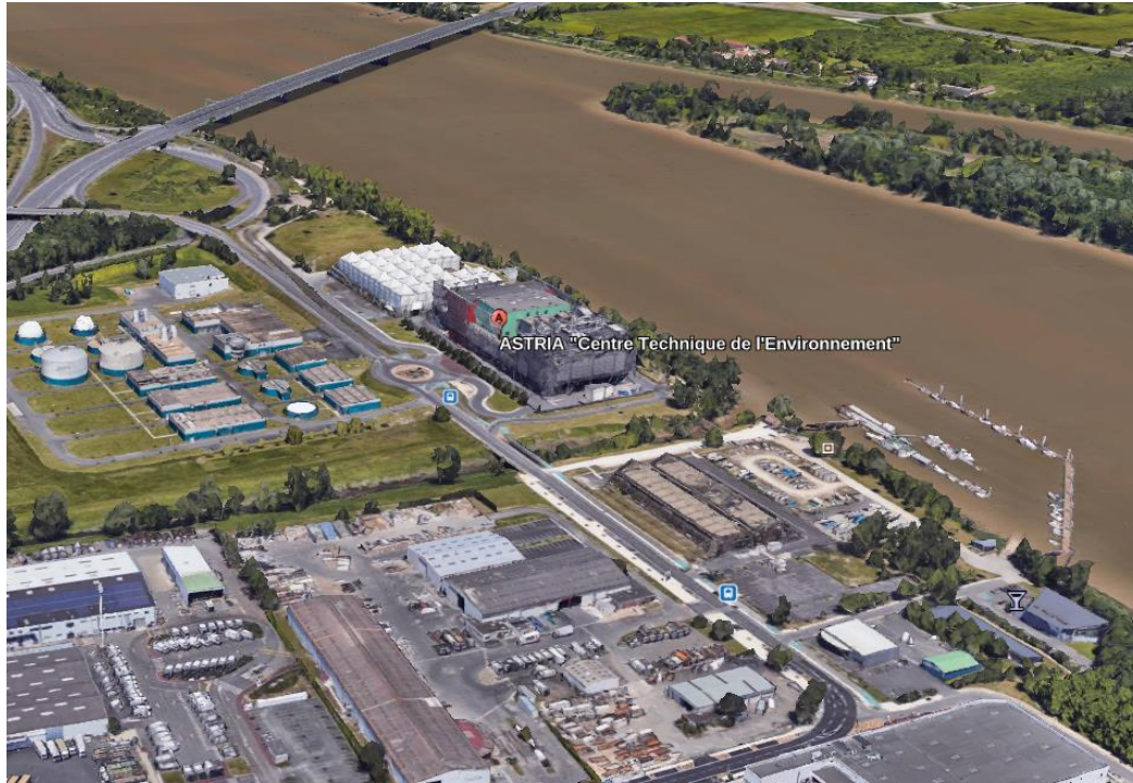
Figure 4 : Vue aérienne autour de l'UVE de Bègles, (source Google earth)
