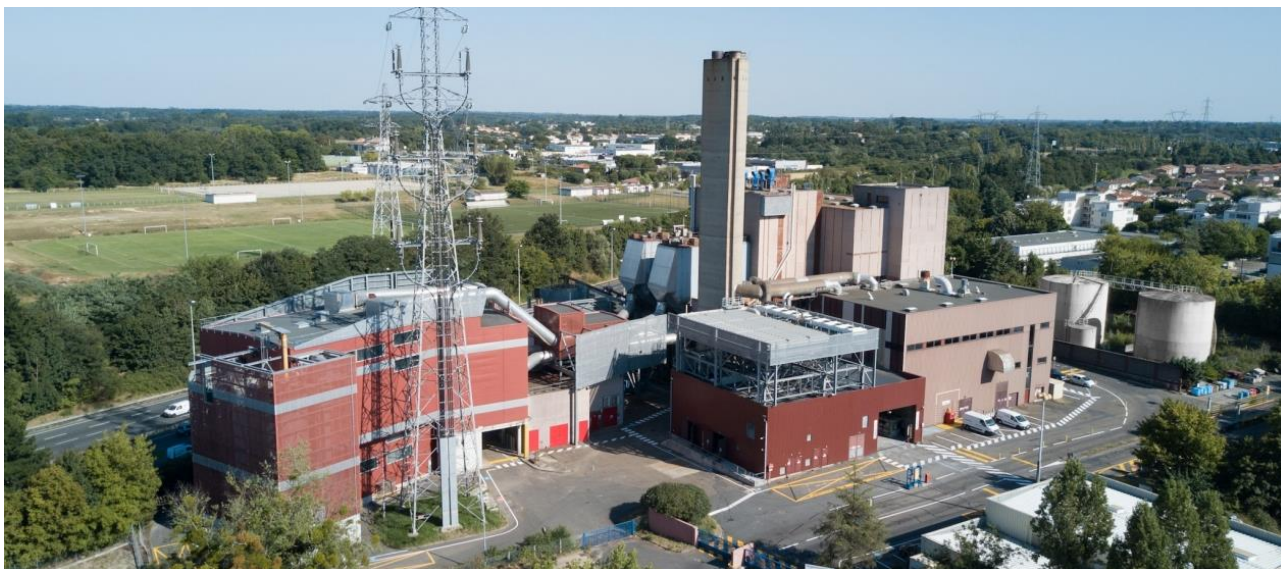
Figure 5 : Complexe thermique des Hauts de Garonne (Cenon), source RIVEDROITEENVIRONNEMENT
