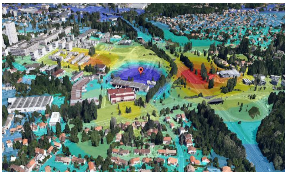
Figure 94 | Vue aérienne des bâtiments les plus exposés autour de la chaufferie (NB : le bâtiment de la chaufferie, dont l'emplacement est signalé en rouge, n'apparaît pas sur la photographie), (source Google Earth)
