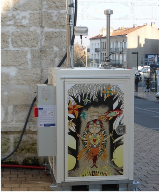
Illustration 1: Station "trafic Angoulême" sur la rue Gambetta
